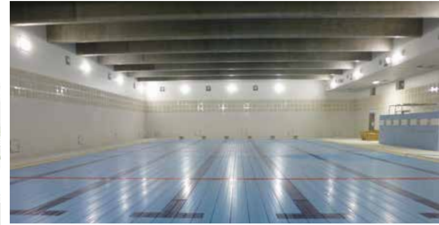
古橋建築事務所
